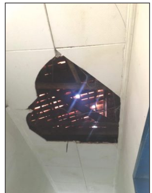
▲ Forro de gesso praticamente desmoronando
